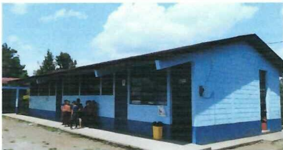
Foto1: CAMBIO DE LAMINAS A TROQUELADAS CALIBRE 26, SEGÚN ESPECIFICACIONES RECIBIDAS, EN MODULO No. 2
