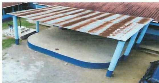
Foto 5: MODIFICACION DE ESTRUCTURA Y CAMBIO DE TECHO A LAMINA TROQUELADA DEL ESCENERIO UBICADO FRENTE A MODULO No. 1
