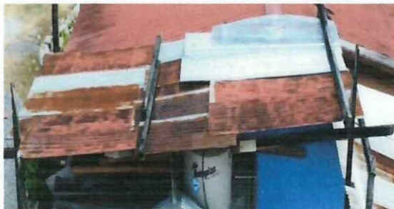
Foto 4: CAMBIO DE ESTRUCTURA Y TECHO DE 4 MTS UBICADA SOBRE LOS DEPOSITOS DE AGUA (TINACOS)
