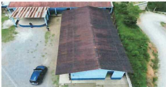
Foto 3: INSTALACION DE CANALES DE METAL EN LA PARTE DE ENFRENTÉ DEL MODULO, INCLUYENDO BAJADAS DE AGUA.
