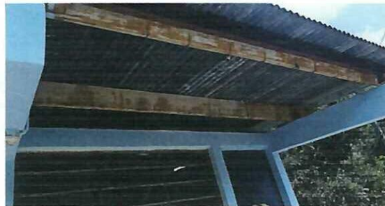
Foto 2: CAMBIO DE ESTRUCTURA, VIGAS Y COSTANERAS DE ALUMINIO GALVANIZADO, INCLUYENDO PINTURA DE COLOR AZUL NACIONAL
